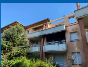
Le mur de refend vue du sol
